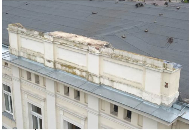
ATTYKA ŚROGKOWA PO DEMONTAŻU ELEMENTU W OSI ŚRODKOWEJ
