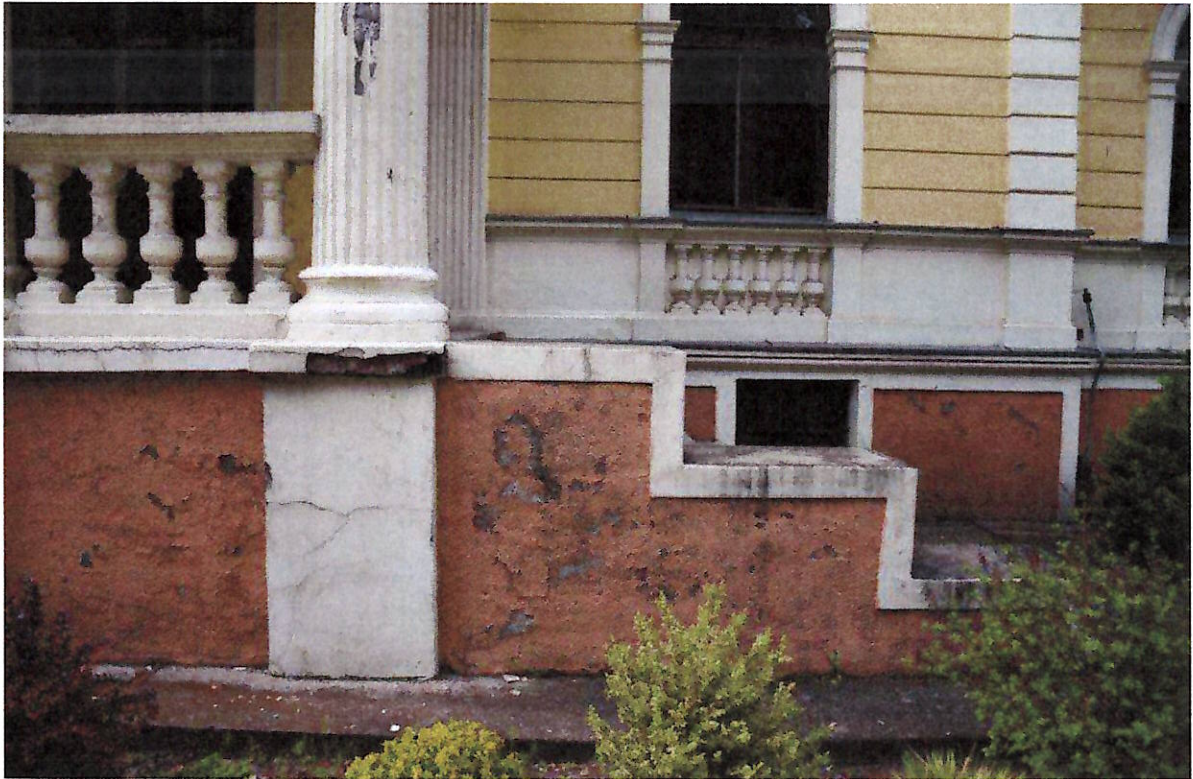
Fotografia 5: Zniszczenia i zawilgocenia tynku w dolnej części portyku.
