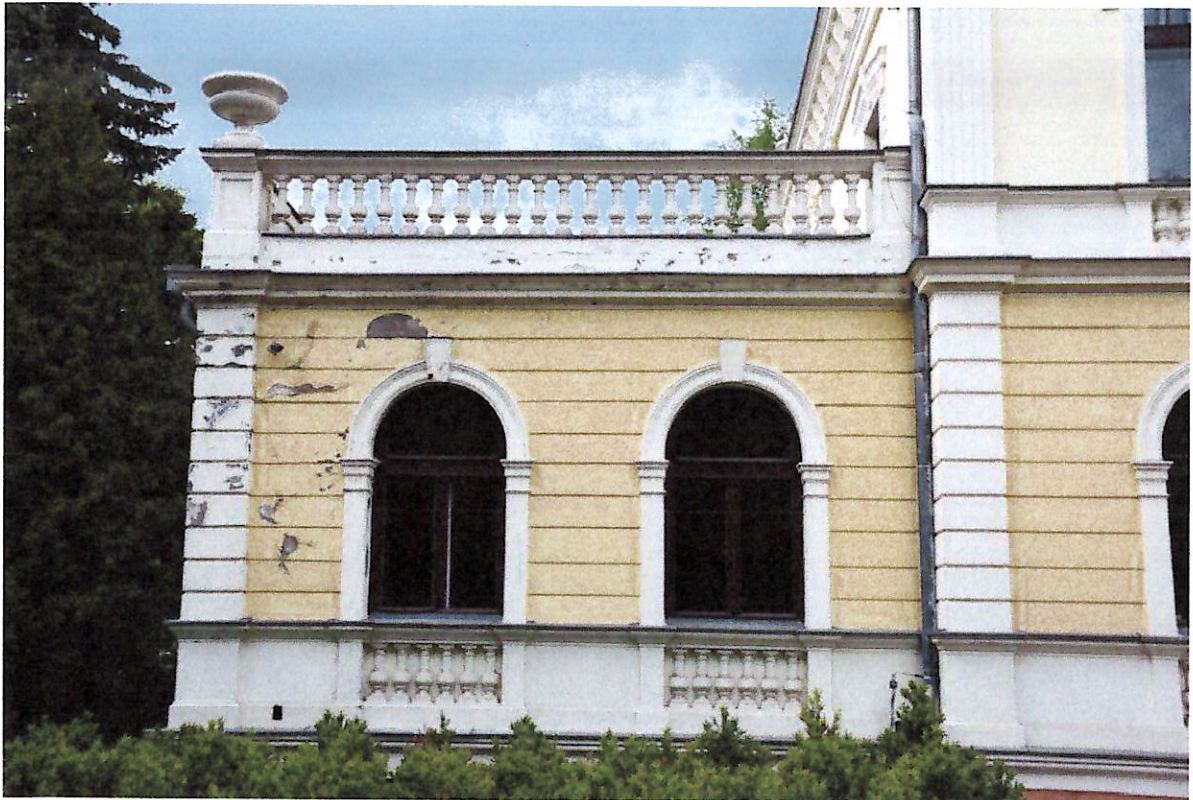
Fotografia 3: Zniszczenia tynków w narożach.
