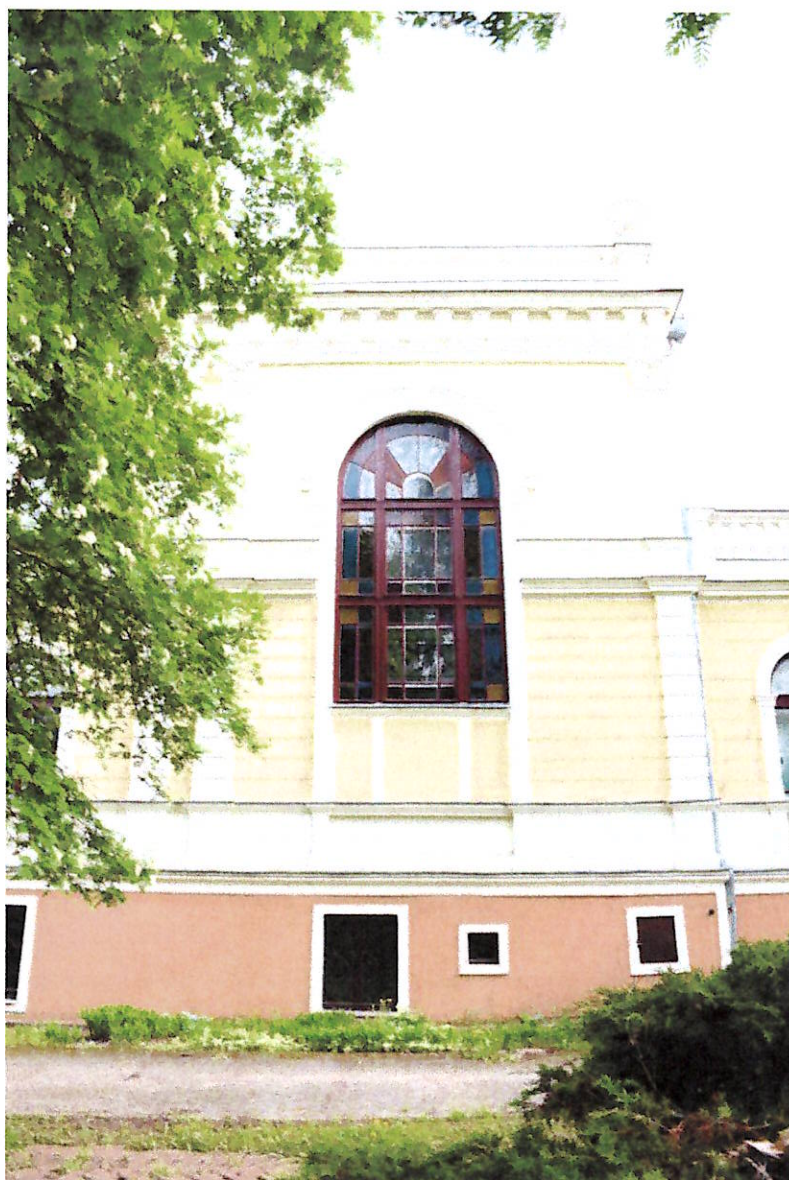
Fotografia 18: Okno znajdujące się klatce schodowej. W dolnej pasie widoczne pęknięcia wymagające zszycia prętami.
