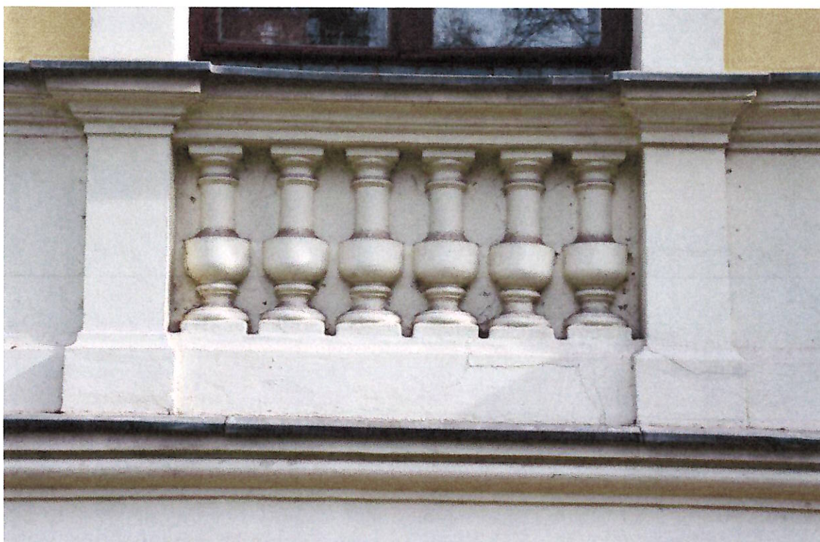
Fotografia 15: Łuszczące się wyprawy tynkarskie przy elementach sztukatorskich. Do usunięcia w toku prac.
