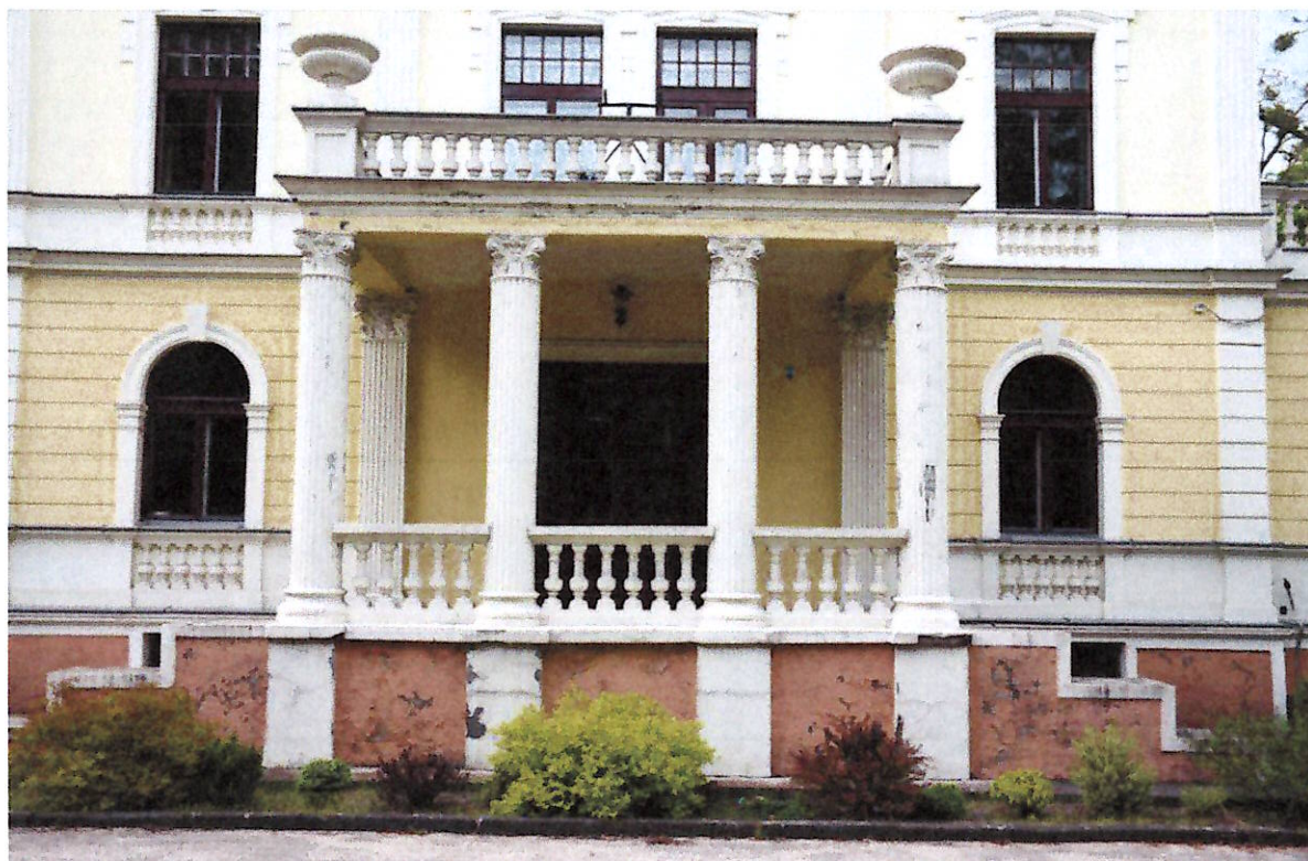
Fotografia 2: Balkon i portyk. Widoczne zniszczenia części cokołowej, zawilgocenia gzymsu balkonu oraz popękany trzon kolumny.
