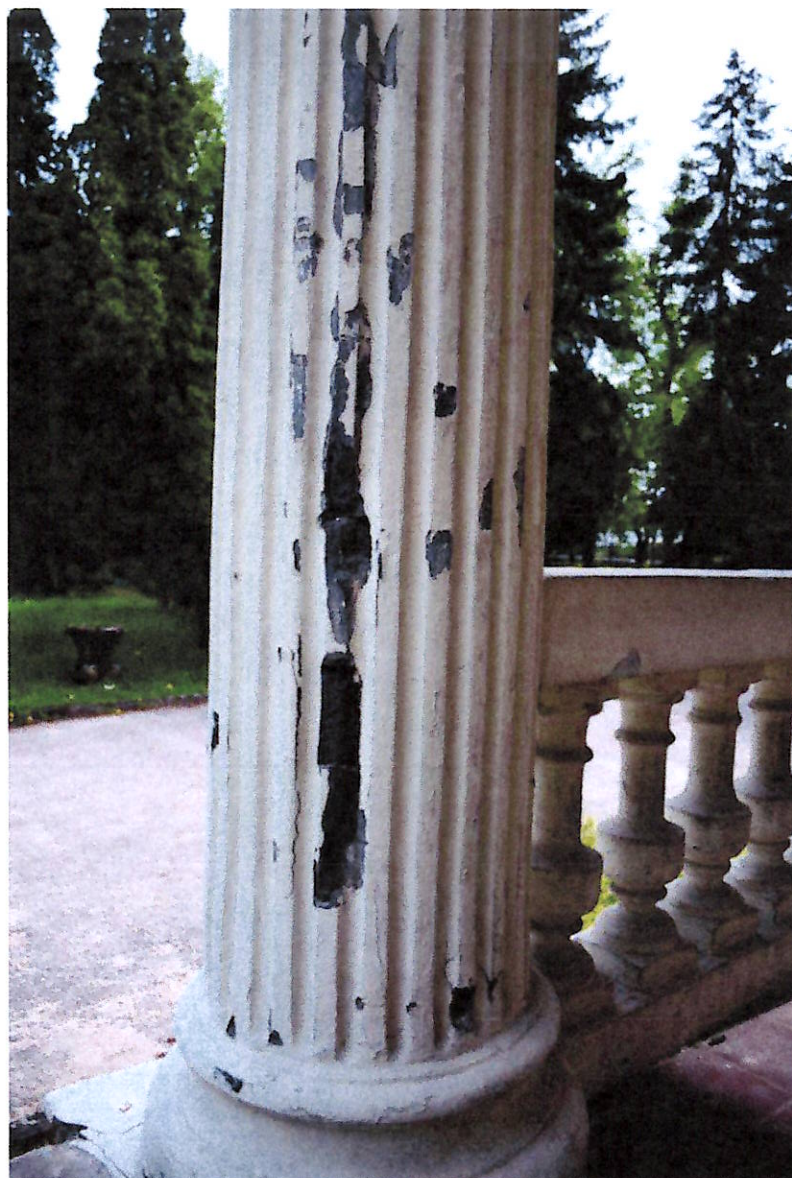
Fotografia 10: Spękany trzon kolumny. Wykonany z mocnej zaprawy cementowej. Do skucia i rekonstrukcji.
