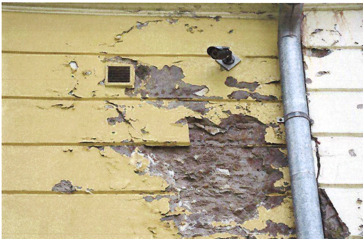
Fotografia 14: Zniszczenia wywołane nieszczelnościami tarasu.
