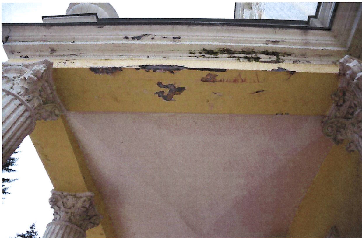
Fotografia 8: Zawilgocenie i zasolenie balkonu spowodowane nieszczelnymi izolacjami.
