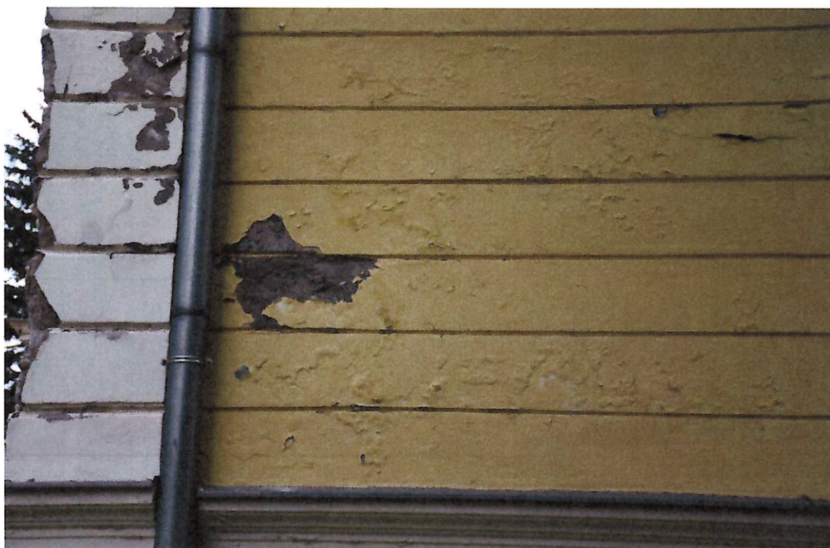
Fotografia 13: Łuszczące się wyprawy malarskie oraz zniszczenia boniowania. Bo usunięcia i rekonstrukcji.
