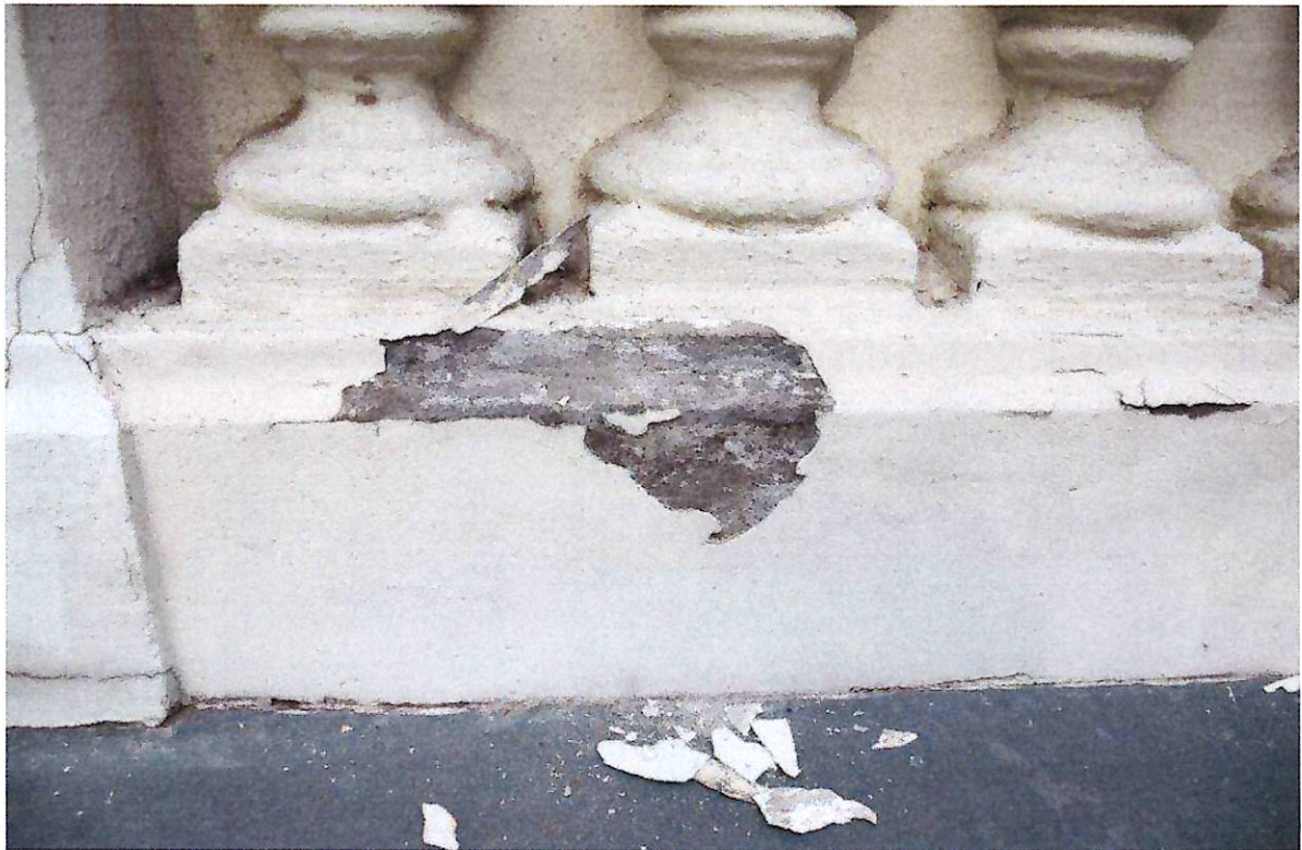
Fotografia 16: Zbliżenie za złuszczoną warstwę wierzchniego tynku założonego na zawilgoconą zaprawę.
