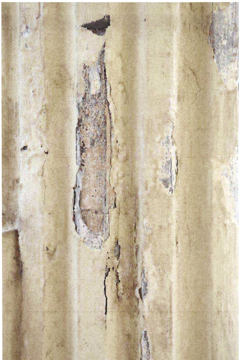
Fotografia 11: Odkrywka pierwotnego koloru znajdująca się na kolumnie. Widoczne wtórne warstwy zapraw do usunięcia w toku prac.
