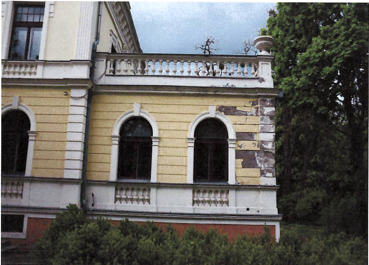
Fotografia 4: Odparzony tynk w narożniku pałacu spowodowany gromadzącą się wodą.
