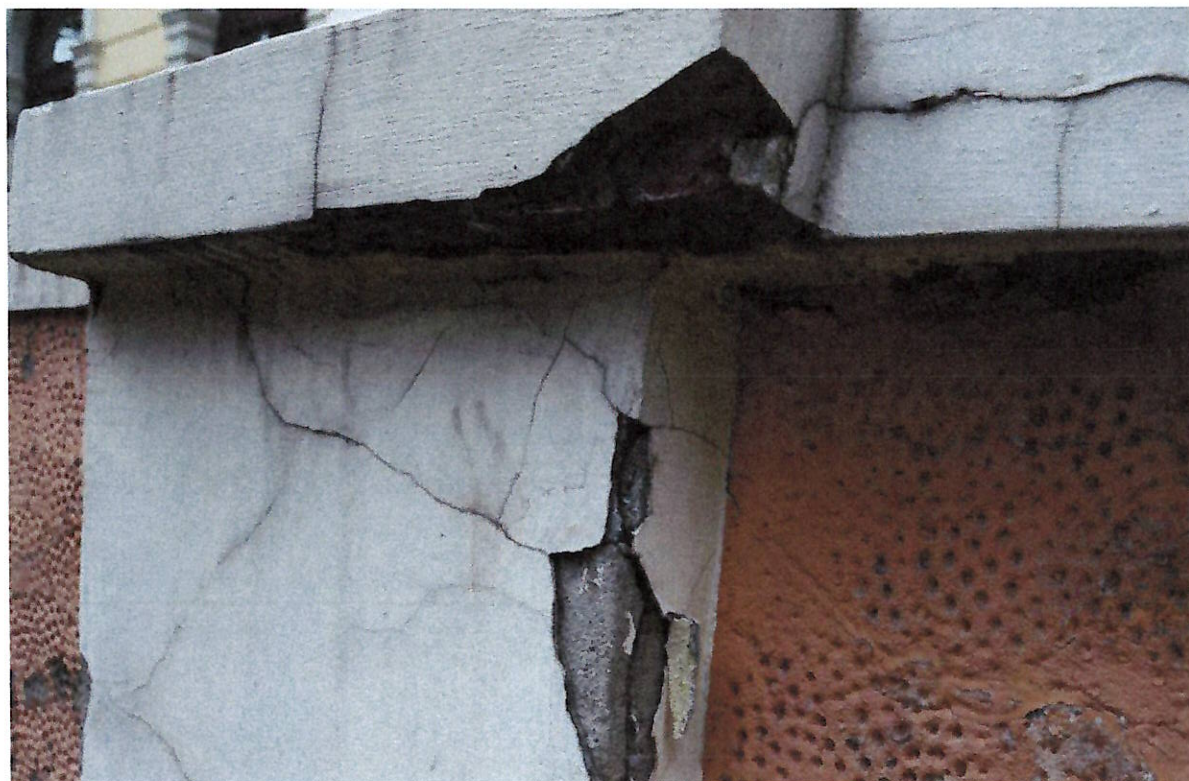
Fotografia 9: Łuszczące się wyprawy tynkarskie pochodzące z czasu ostatniego remontu.
