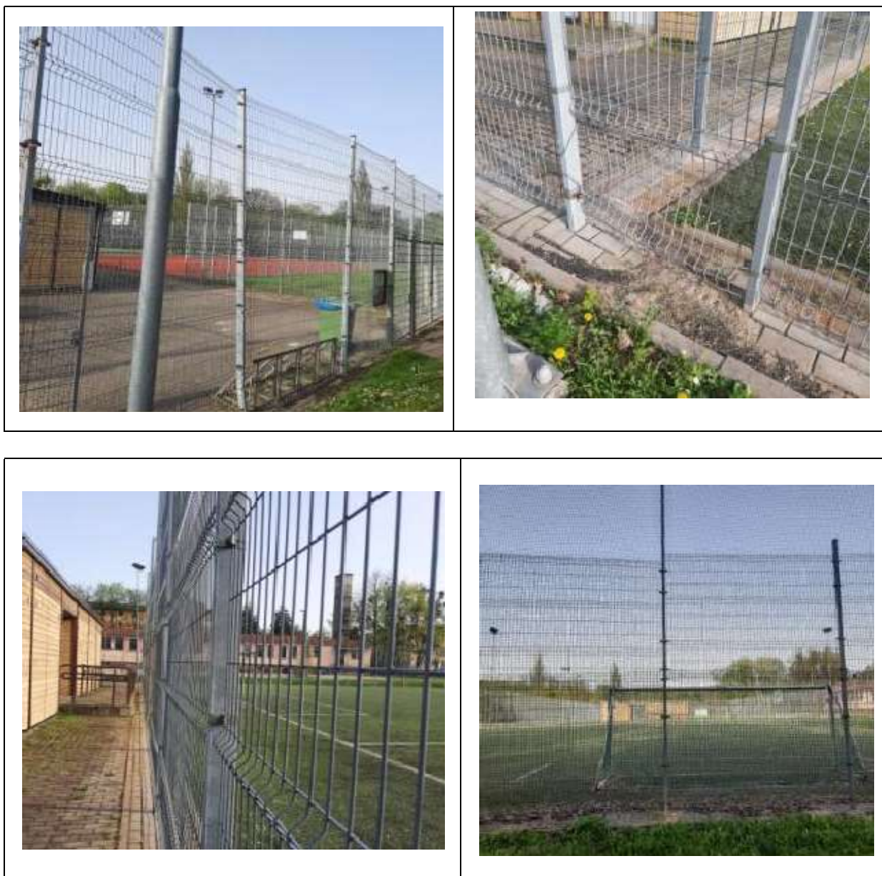
Fot.4. Widok uszkodzonych paneli ogrodzeniowych do wymiany
