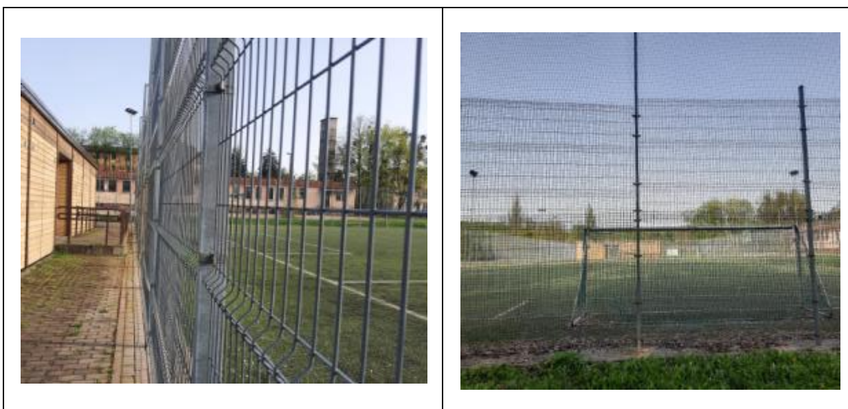
Fot.4. Widok uszkodzonych paneli ogrodzeniowych do wymiany
