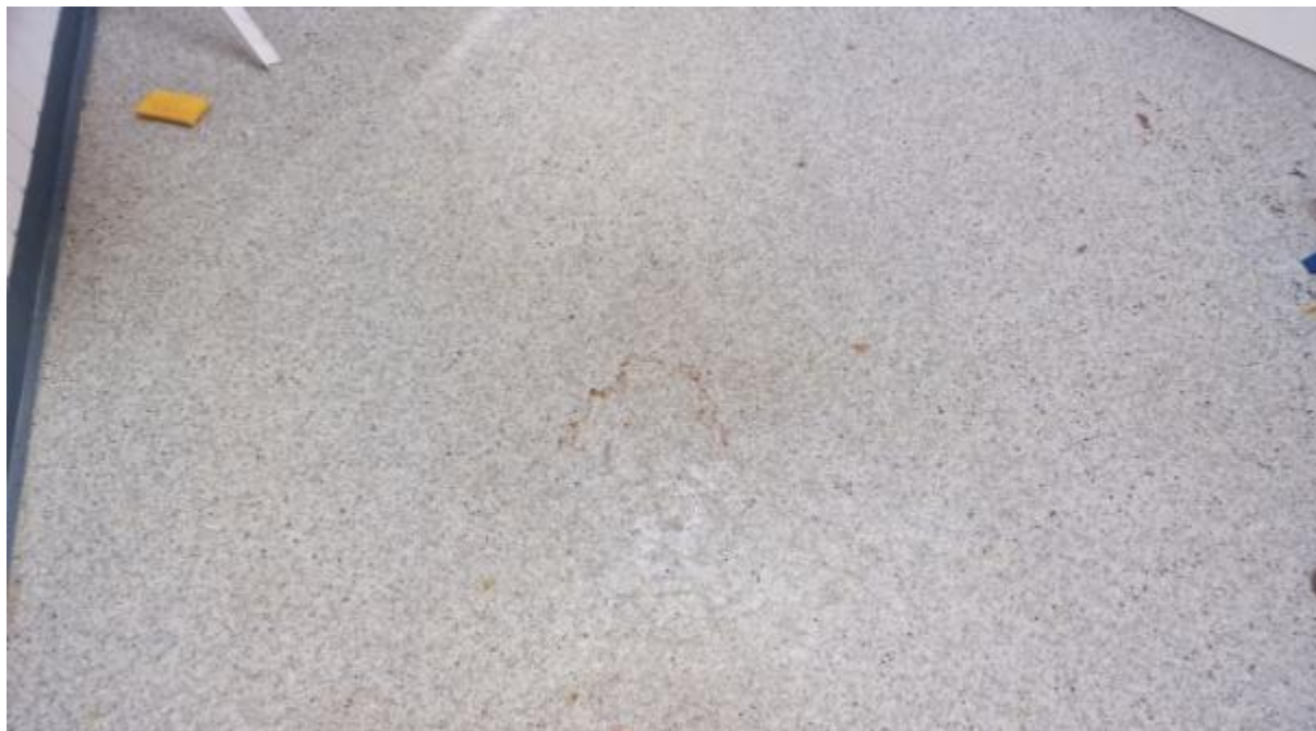
Fot. nr 1. Widoczne odkształcenia spowodowane załamaniem konstrukcji.
