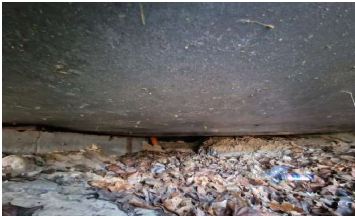
Fot. nr 2. Widok obwieszanej blachy ocynkowanej.
