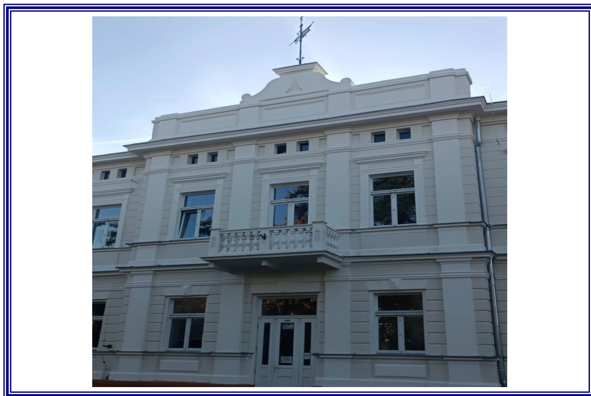
Rewitalizacja budynku Liceum Ogólnokształcącego w Ciechocinku
