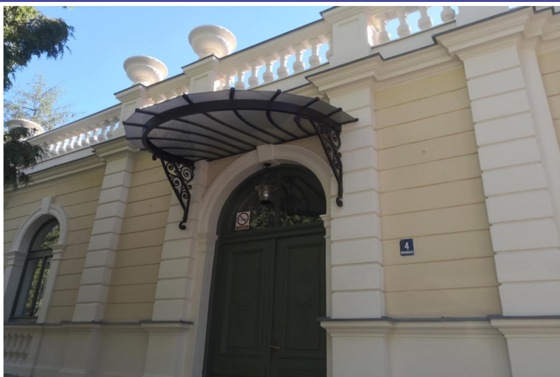
Odrestaurowanie zewnętrzne zabytkowego budynku pałacu Trojanowskich
