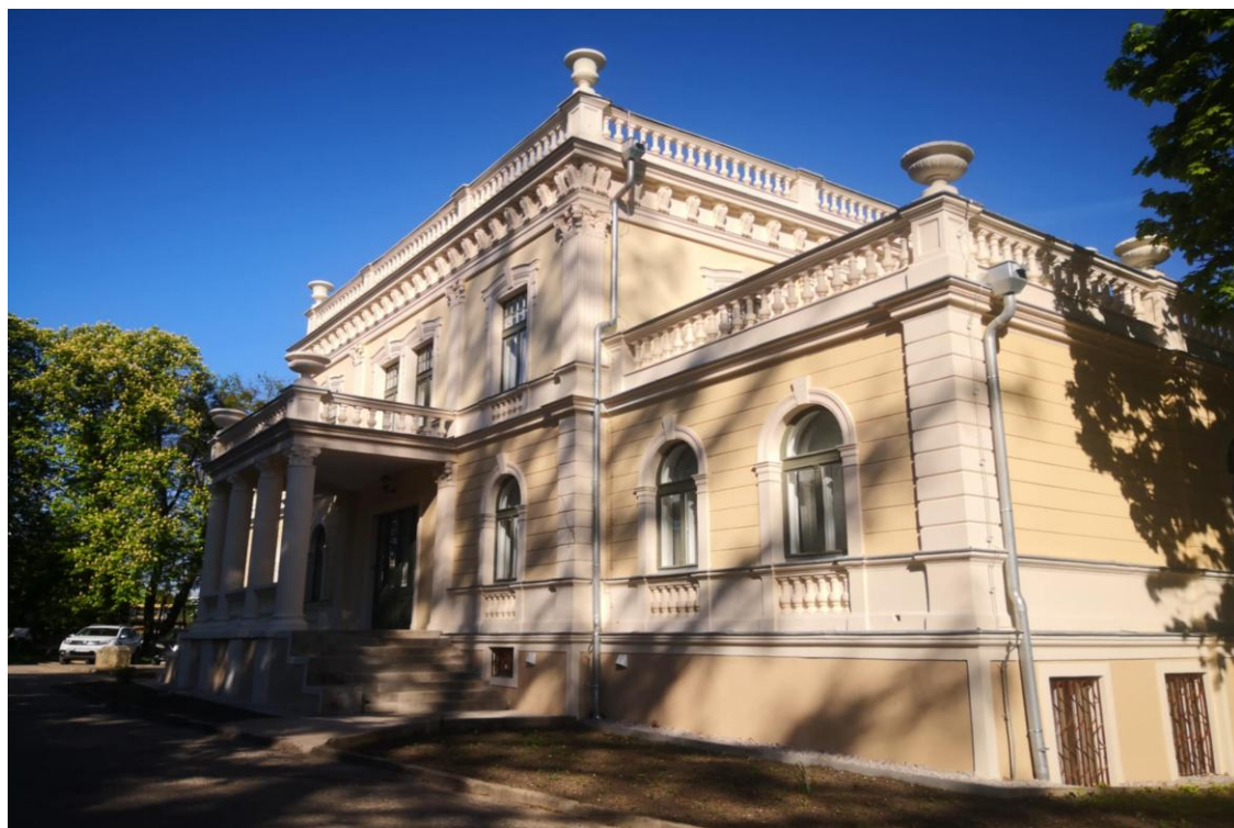
Odrestaurowanie zewnętrzne zabytkowego budynku pałacu Trojanowskich
