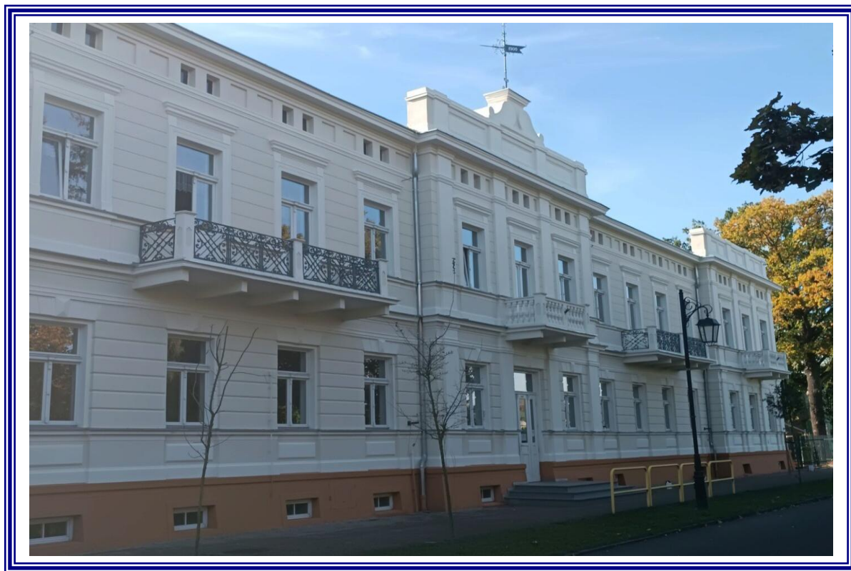
Rewitalizacja budynku Liceum Ogólnokształcącego w Ciechocinku
