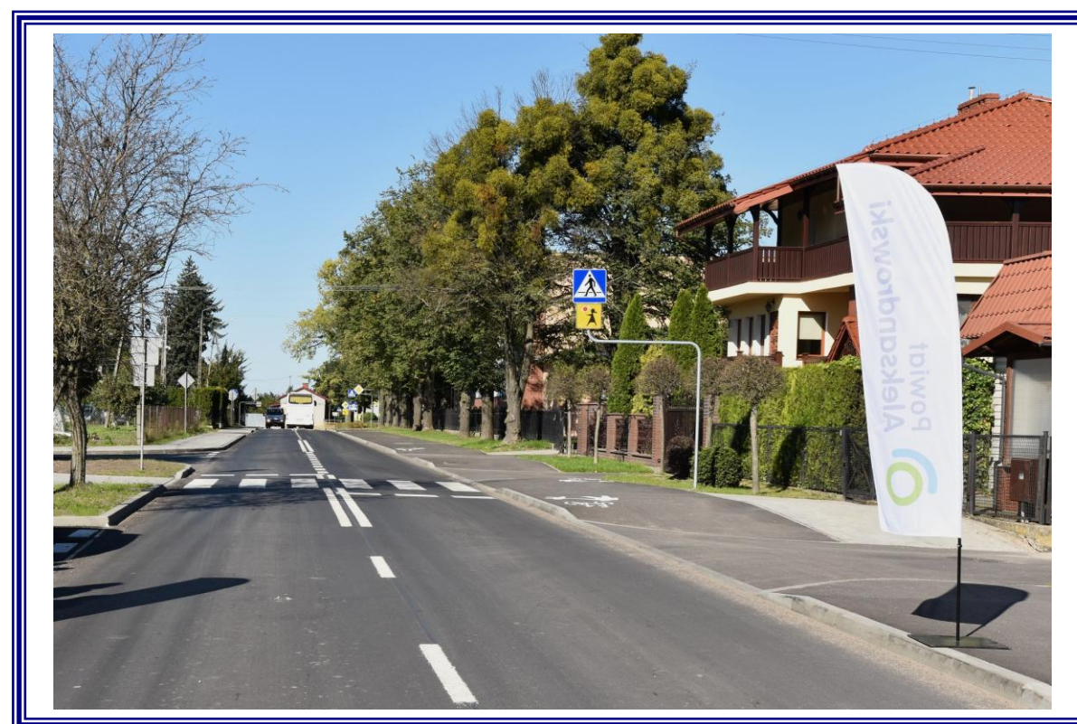
Przebudowa drogi powiatowej nr 2602C Ciechocinek – Dąbrówka w miejscowości Raciążek – etap I (ul. Szkolna)
