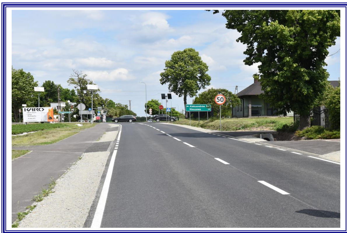
Przebudowa drogi powiatowej nr 2607C Ośno - Zazdromin – etap II
