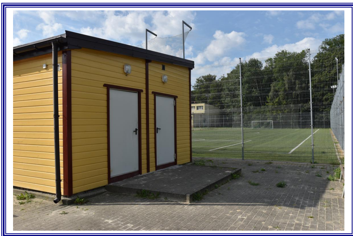
Modernizacja kompleksu sportowego „Moje Boisko – Orlik 2012” w Aleksandrowie Kujawskim przy ul. Wyspiańskiego”
