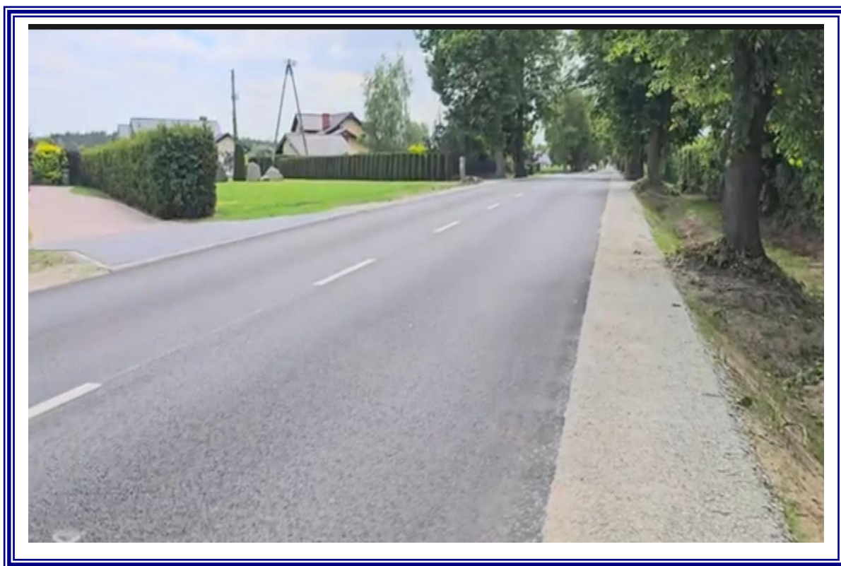
Przebudowa drogi powiatowej nr 2603C Ciechocinek – Siutkowo – etap V
