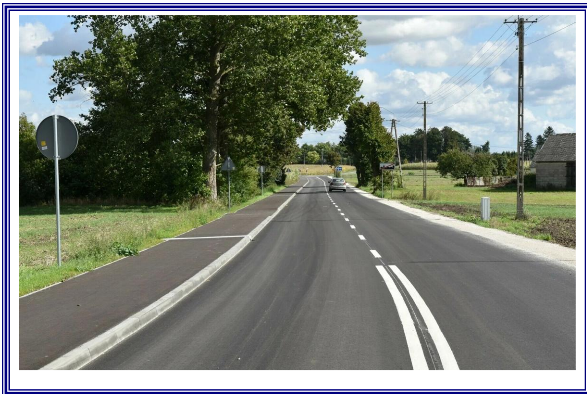
Przebudowa drogi powiatowej nr 2608C Konradowo – Siniarzewo – etap I w miejscowości Siniarzewo, Sinki, gmina Zakrzewo
